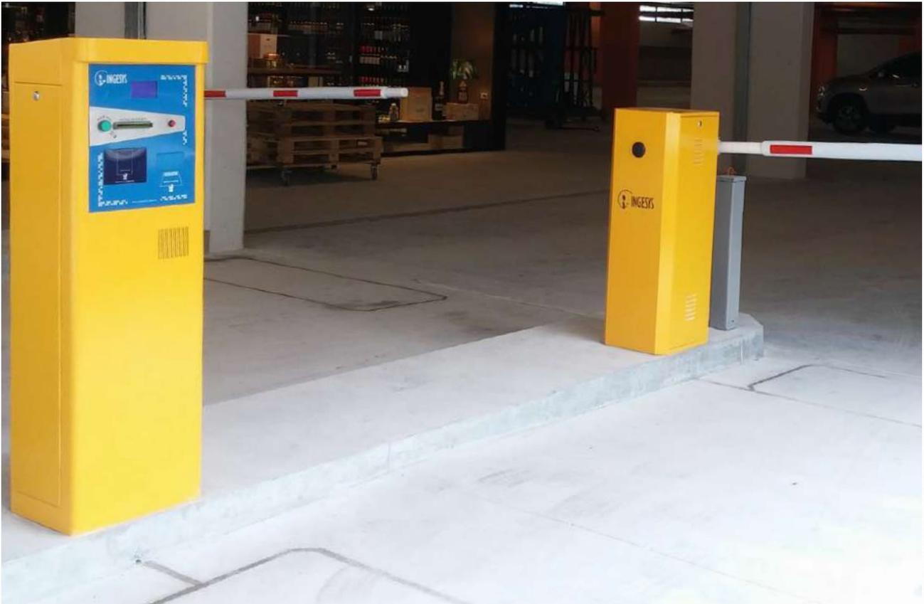
Está compuesto por barreras de última generación y por expendedores de tickets, integrados a un software de gestión diseñado especialmente para estacionamientos.
